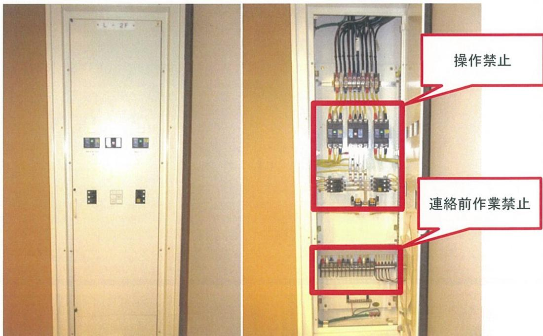
※ビル側分電盤のブレーカー操作はビル設備員以外は**禁止**
